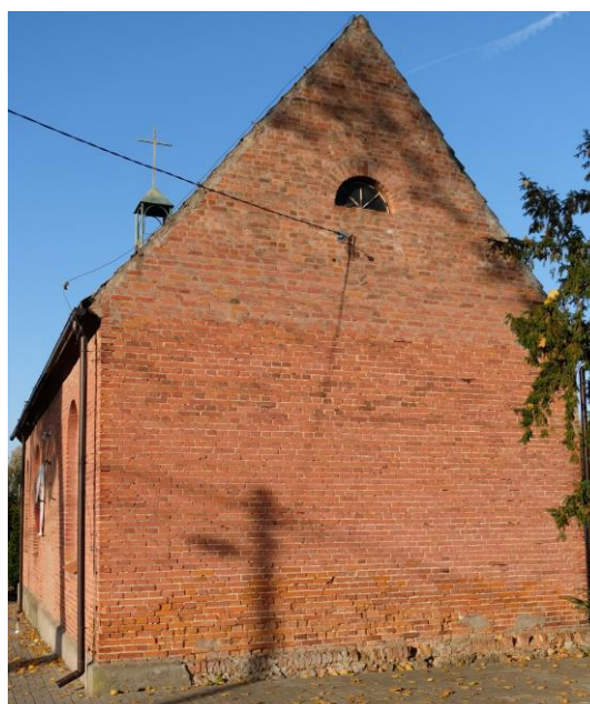
Kościół elewacja wschodnia.
